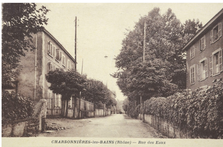
L'ancienne Rue des Eaux devenue Avenue du Général de Gaulle et récemment réaménagée.
