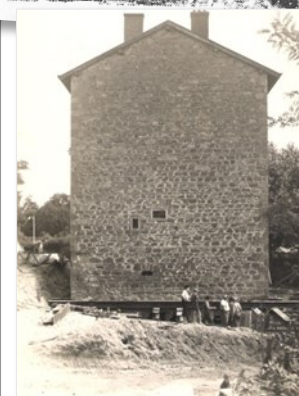
La maison en cours de translation
