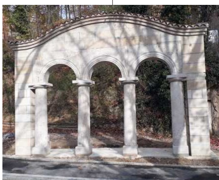
Les arcades sur leur nouvel emplacement
