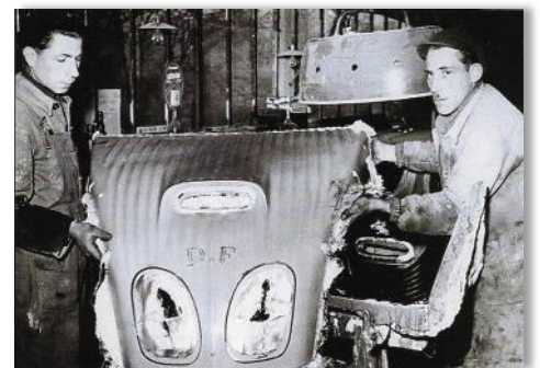
Fabrication d'un capot en fibre de verre
