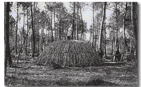
Type de rangement du bois pour constituer une meule destinée à la production du charbon de bois
